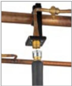
Liebert® XD系统的管道预布置令机房的制冷系统更灵活, 用户可根据升级的系统安装制冷终端。利用这种灵活的快速管道连接装置, 用户可视需要快速增加、断开或重新定位Liebert® XD制冷模块。
